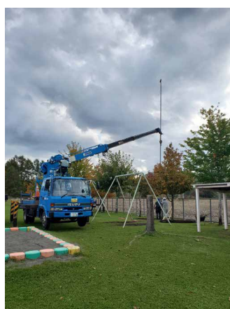
ポール設置工事中
