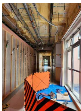
工事中の本園廊下
