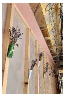
仮囲いのラベンダー
